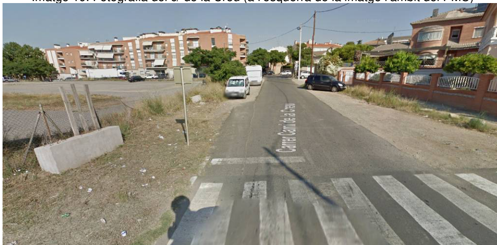
Imatge 19. Fotografia del c/ de la Creu (a l'esquerra de la imatge l'àmbit del PMU)
