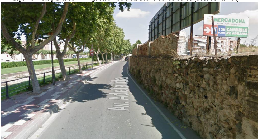
Imatge 16. Fotografia de l'Avinguda d'Adelaida abans de les obres (oest de l'àmbit)
