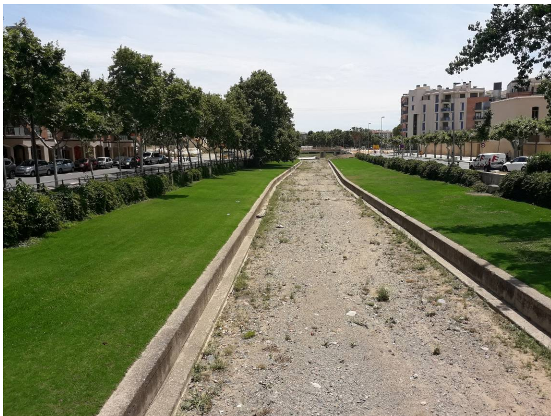
Foto 1: Vista aigües avall de la riera de l'Alforja des del pont de la Creu
