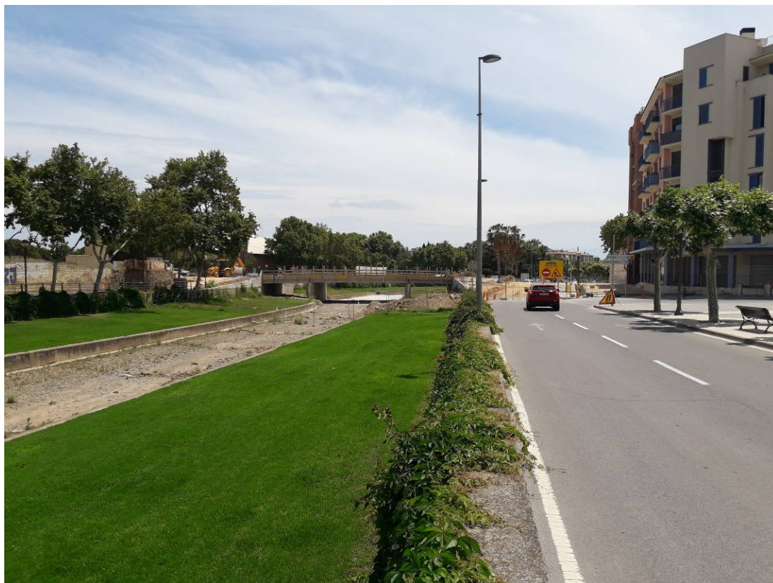
Foto 2: Vista aigües avall de la riera d'Alforja des de passeig de Sant Joan Baptista de la Salle (marge dret), on s'observa el pont de l'antiga N-340 en construcció
