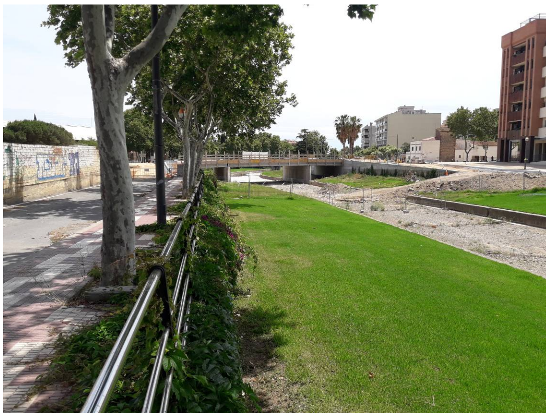
Foto 3: Vista aigües avall de la riera d'Alforja des de l'avinguda Adelaida (marge esquerre) a l'alçada del sector PMU-1 "l'Alforja", on s'observa el pont en construcció.
