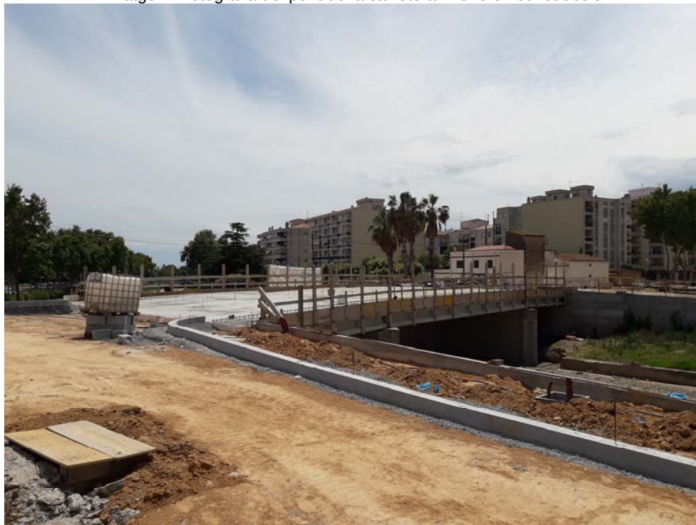
Imatge 7. Fotografia del pont de la carretera N-340 en construcció
