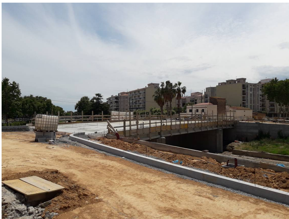
Foto 4: Vista detall construcció del nou pont des de l'interior del sector - carrer Adelaida
