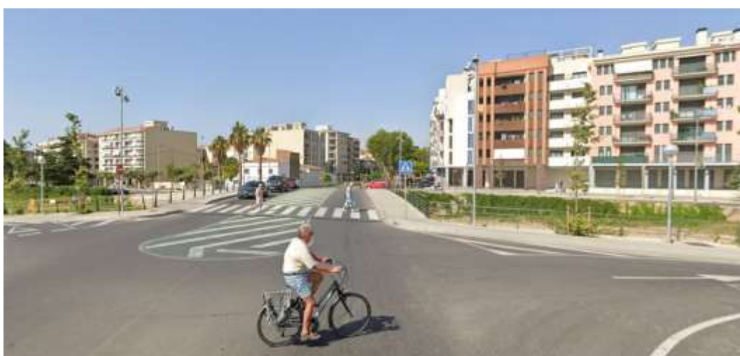
Imatge del pont actual. Font: google maps
