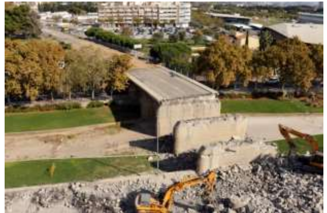
Imatges de l'execució de l'enderrocament del pont
