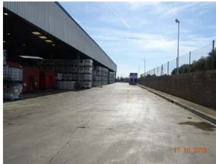
Edificacions zona oest. Límit del pla a la dreta
