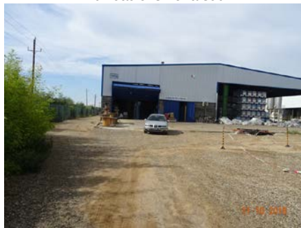
Edificacions zona sud . Vista cap oest
