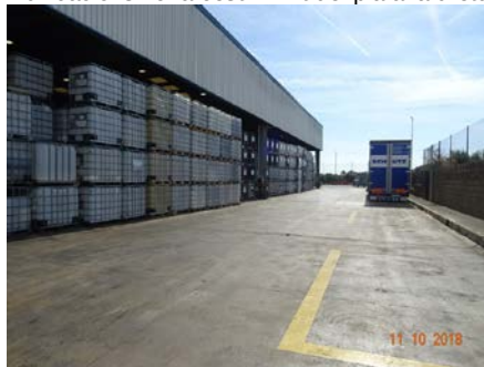
Edificacions zona oest. Límit del pla a la dreta
