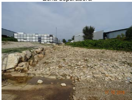
Zona rasa escullera cap a nord. Dreta fora àmbit
