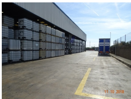
Edificacions zona oest
