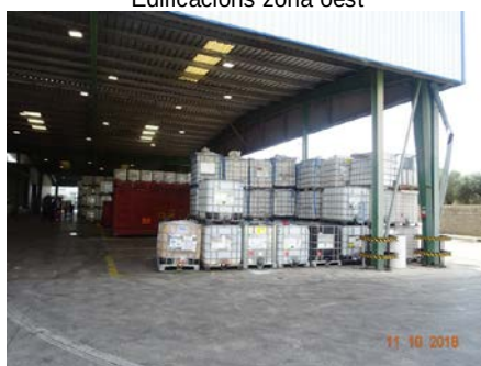
Edificacions zona oest
