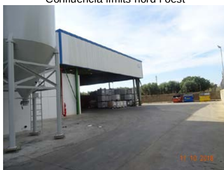
Edificacions zona oest
