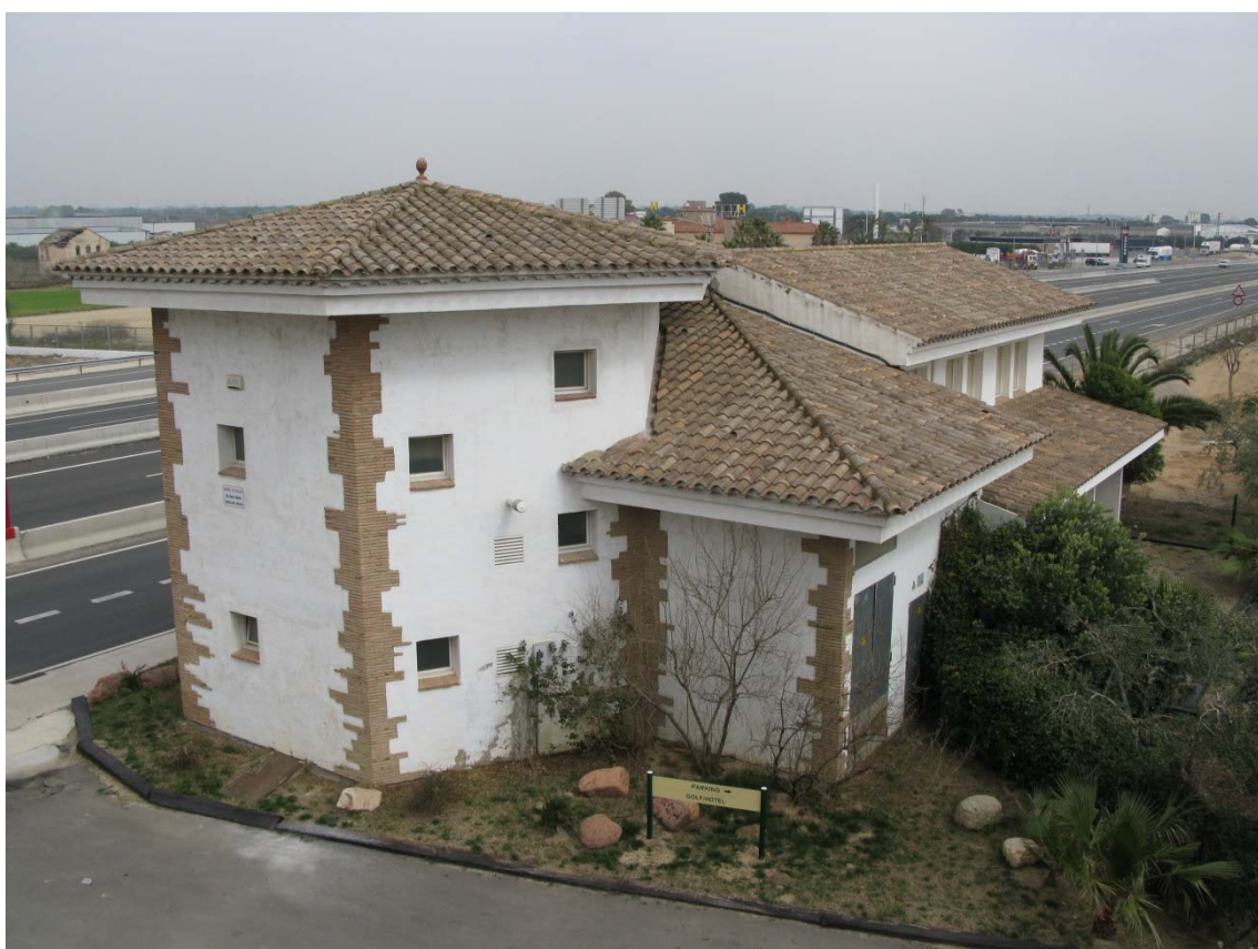
Vista de la nova carretera que passa a 3 metres de l'alineació de l'edificació.
