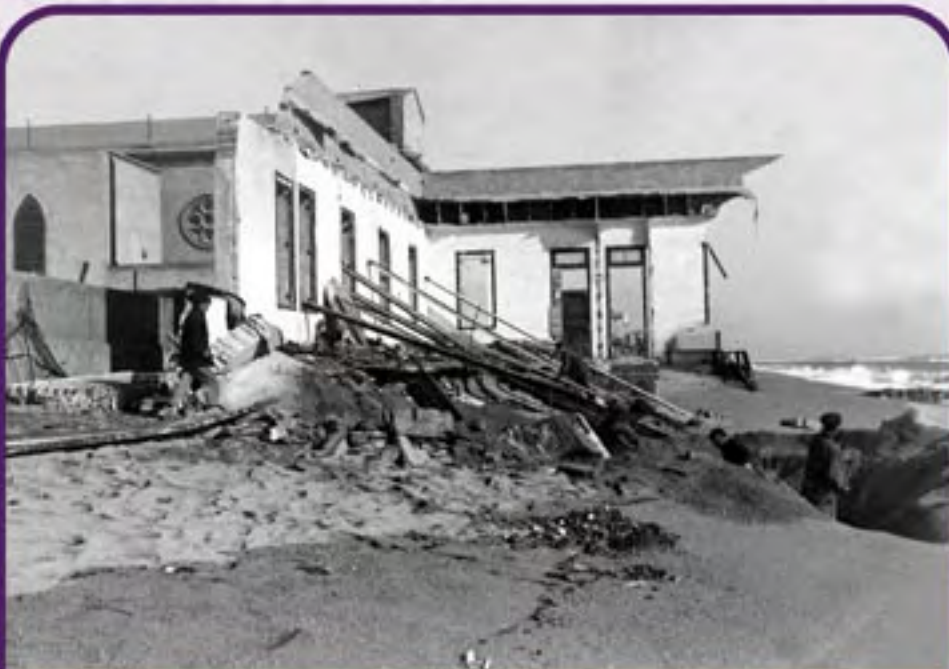
Destrosses provocades pel temporal al barri de Pequín, al Poblenou
