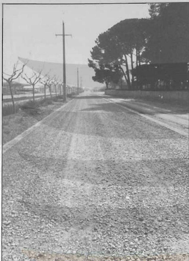
Obres de construcció del vial del Pinaret fins la zona esportiva del Camp de Futbol.
