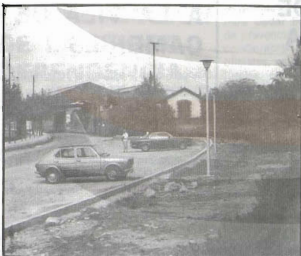
Construcción de aceras frente al Pabellón Municipal.
