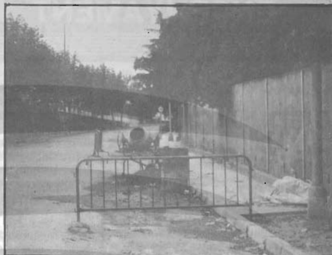
Pavimentación de aceras en Avda. Baix Camp.
