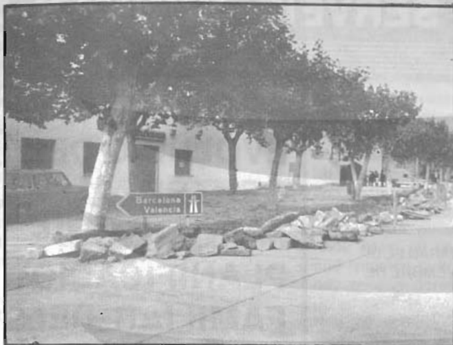
Obras segunda fase Paseo la Salle.
