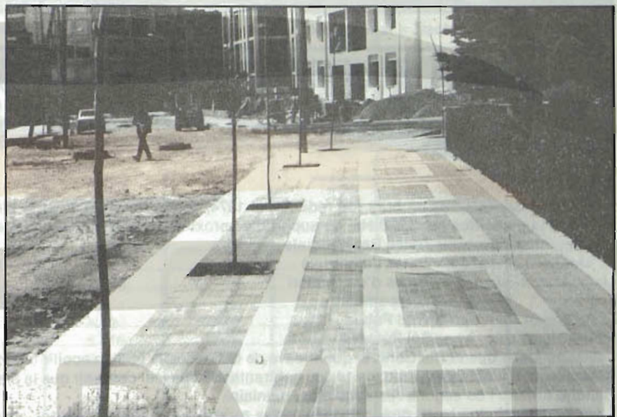
Aspecte voravies obres zona Galceran Marquet
