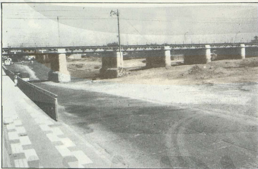
Urbanització Marge Esquerra Riera D'Alforja.
