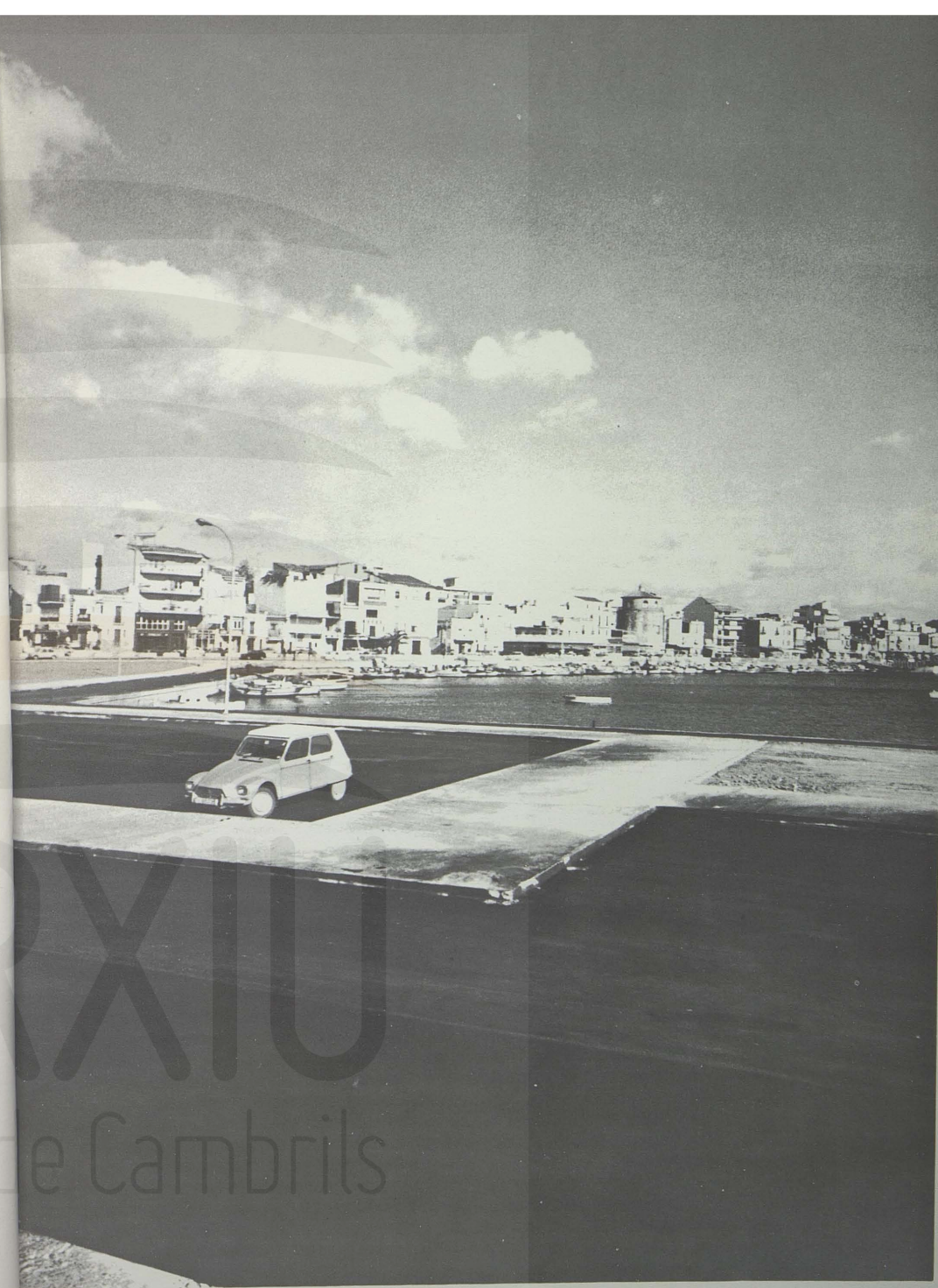
Perspectiva del Puerto con las obras de ampliación del MUELLE DE PONIENTE ya terminadas.
