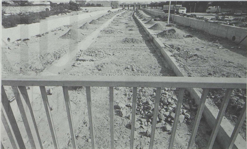
Las obras de encauzamiento a la altura de la calle San Plácido, ya prácticamente terminadas.
