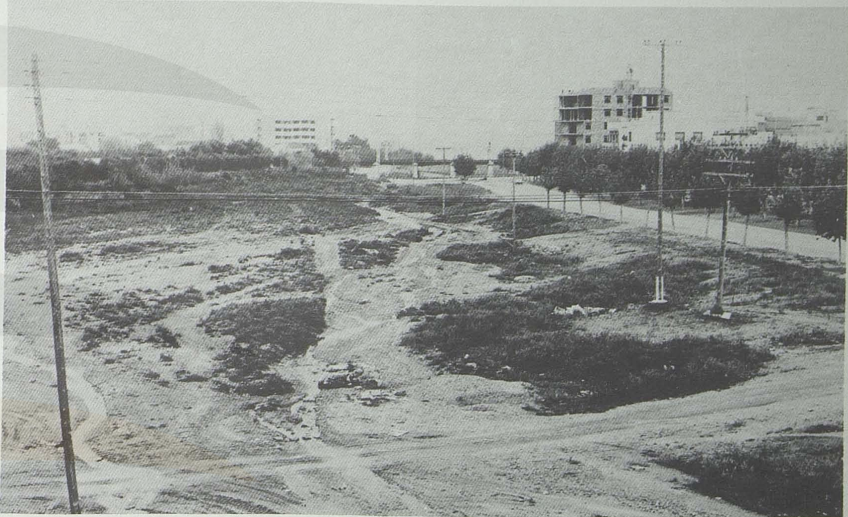
Clásica perspectiva de la Riera antes de las obras del encauzamiento a la altura de calle Joaquina de Vedruna.
