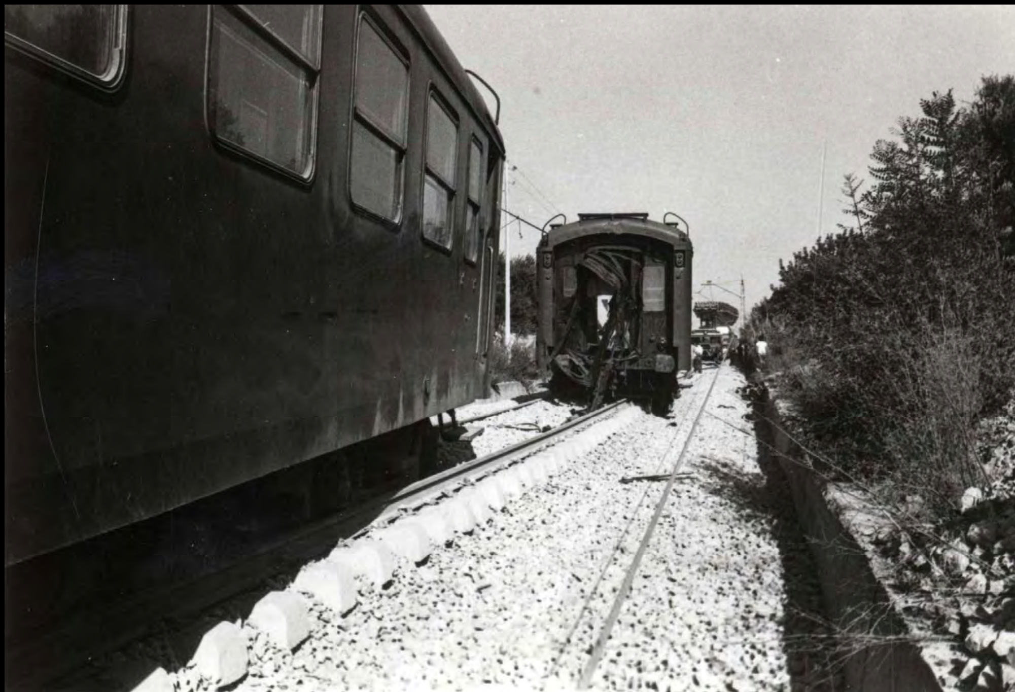
Reparacions del descarrilament d'un tren (ca. 1970)
