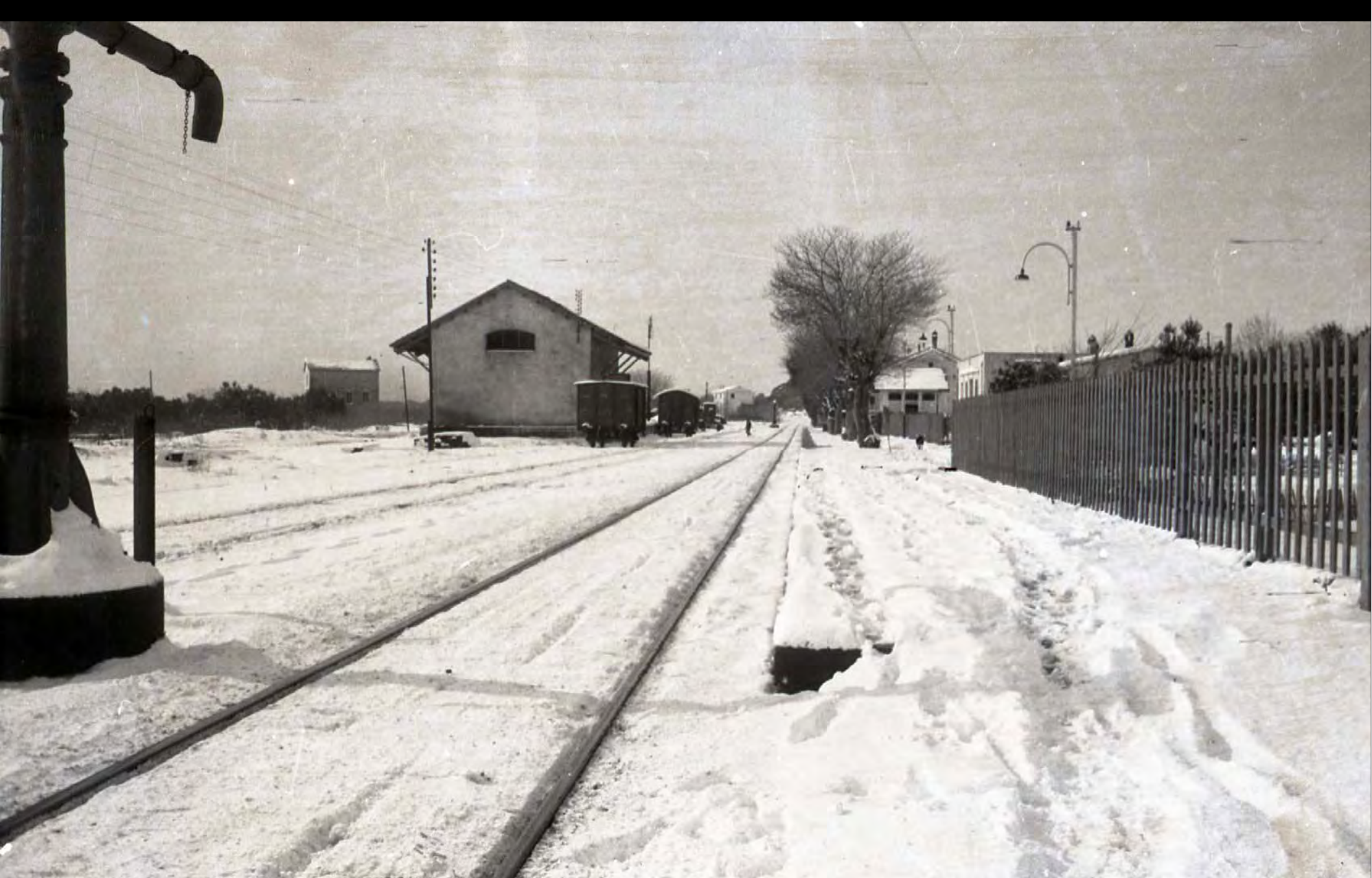
L'estació nevada. En primer terme, punt d'abastiment d'aigua(segurament, el 1962)
