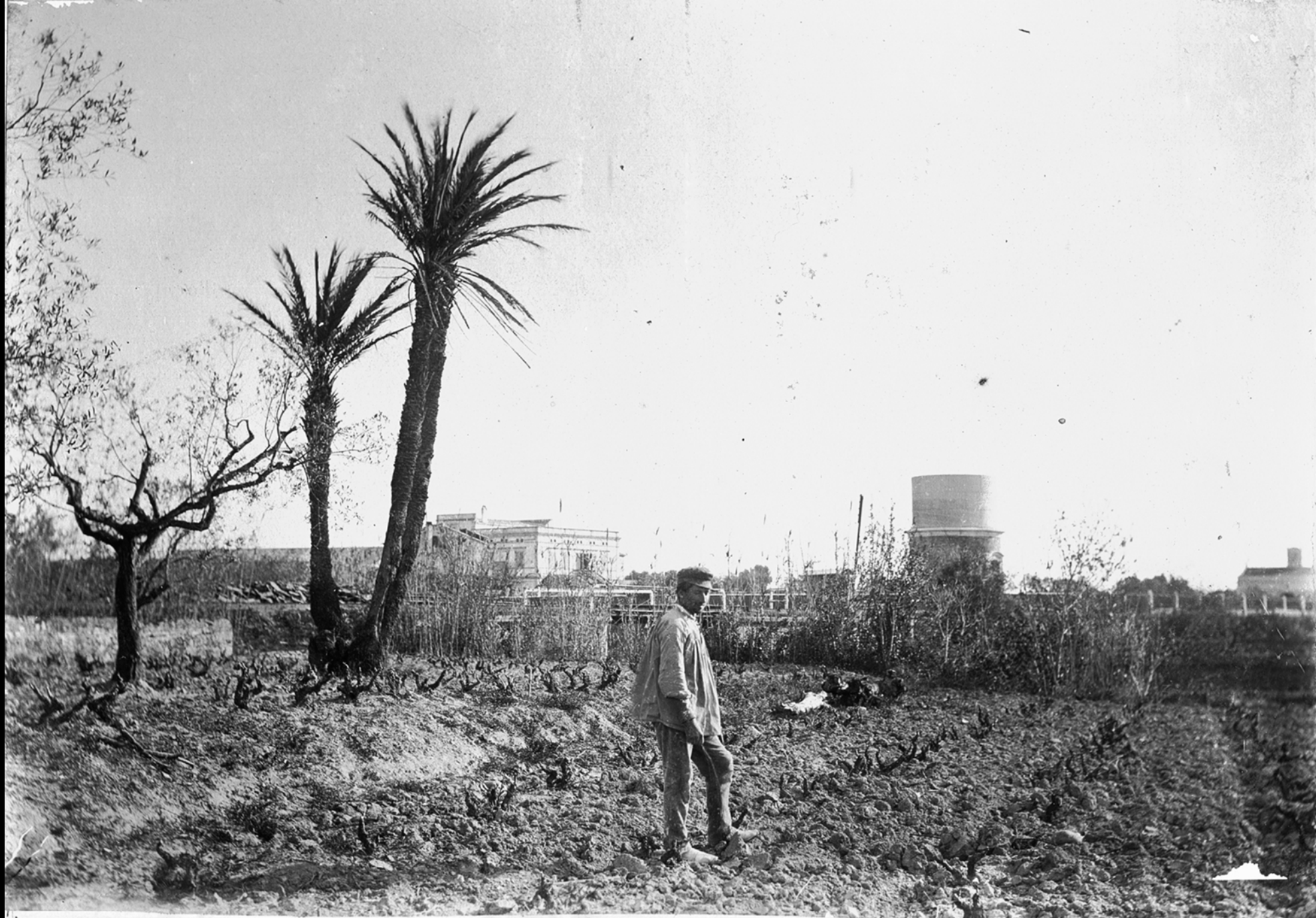
El dipòsit i l'estació, des de la Llosa (ca. 1900)
