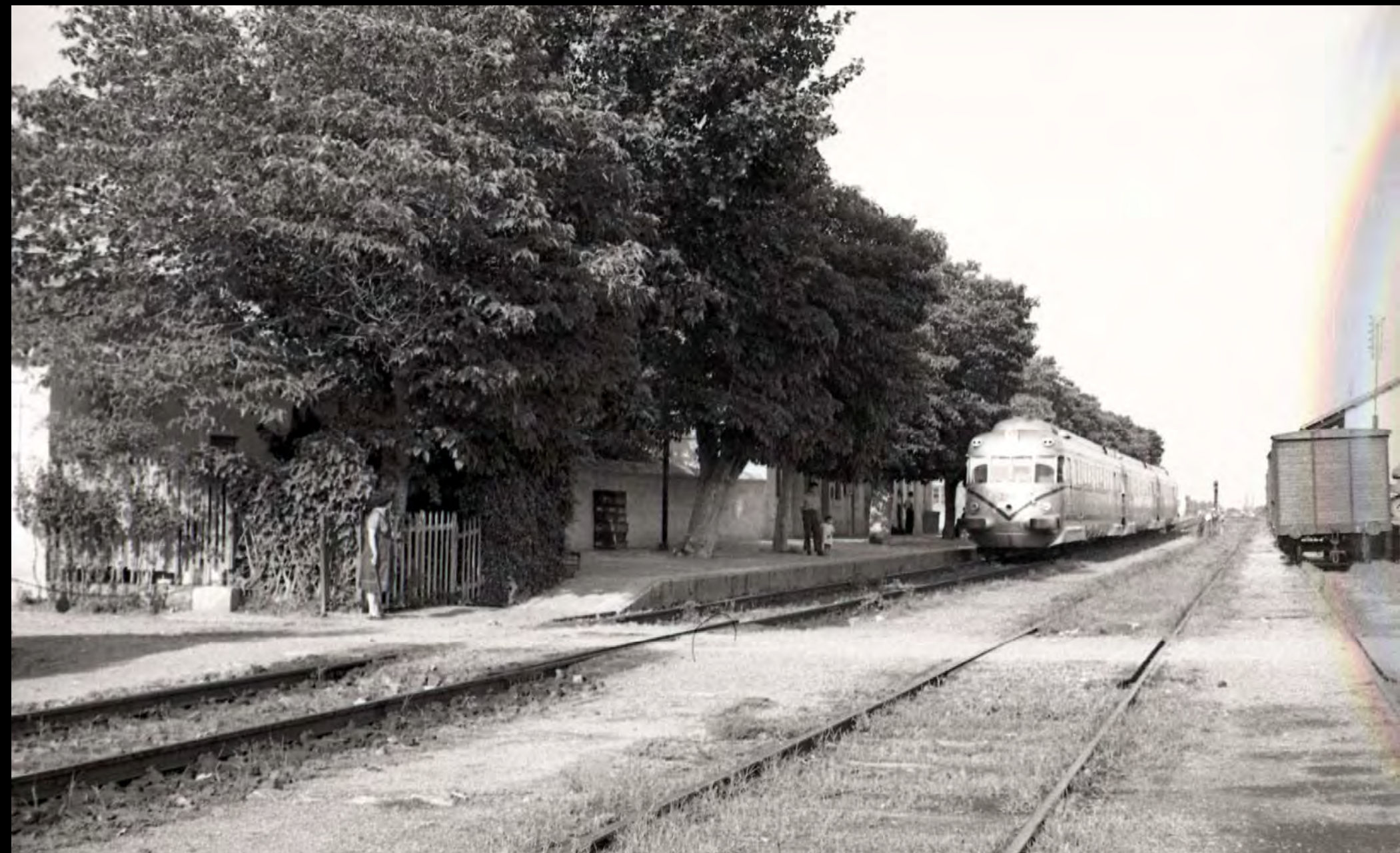
Pas a nivell del carrer Barcelona i andana de l'estació (cap a 1960)
