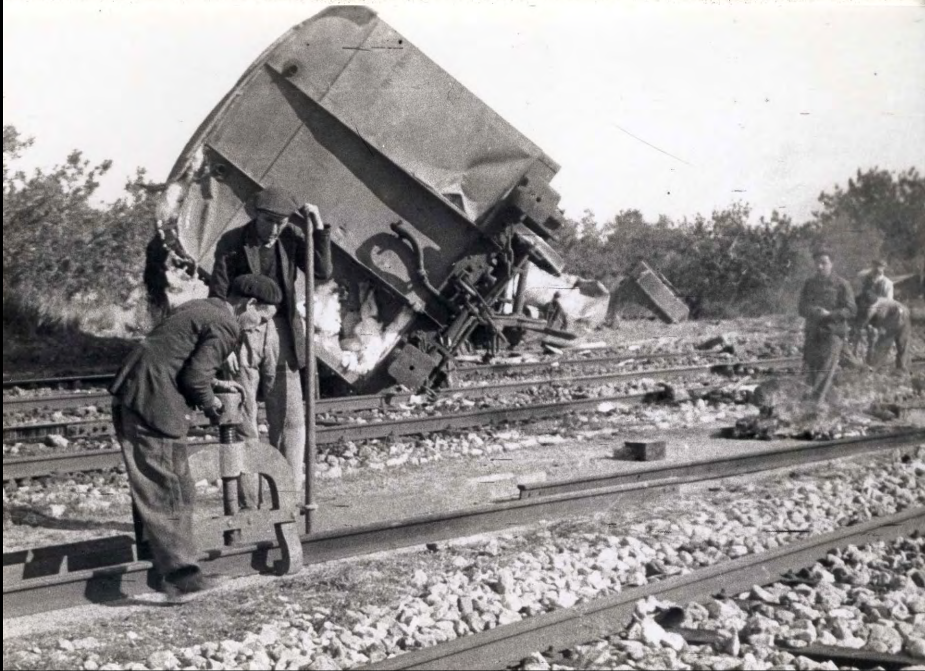
Treballadors de Via i Obres arreglant les vies després d'un descarrilament
