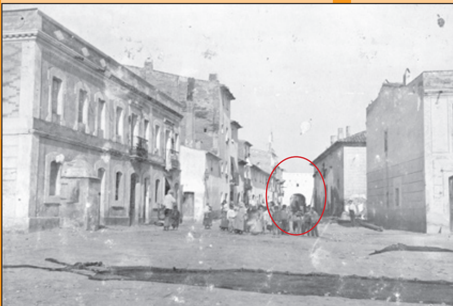
Imatge del carrer de Sant Jordi des del Passeig Miramar. Al fons, encerclat en vermell, es veu el portal per on s'entrava al barri de la Platja (ca. 1900) AMCAM, núm. reg. 9553-1-158
